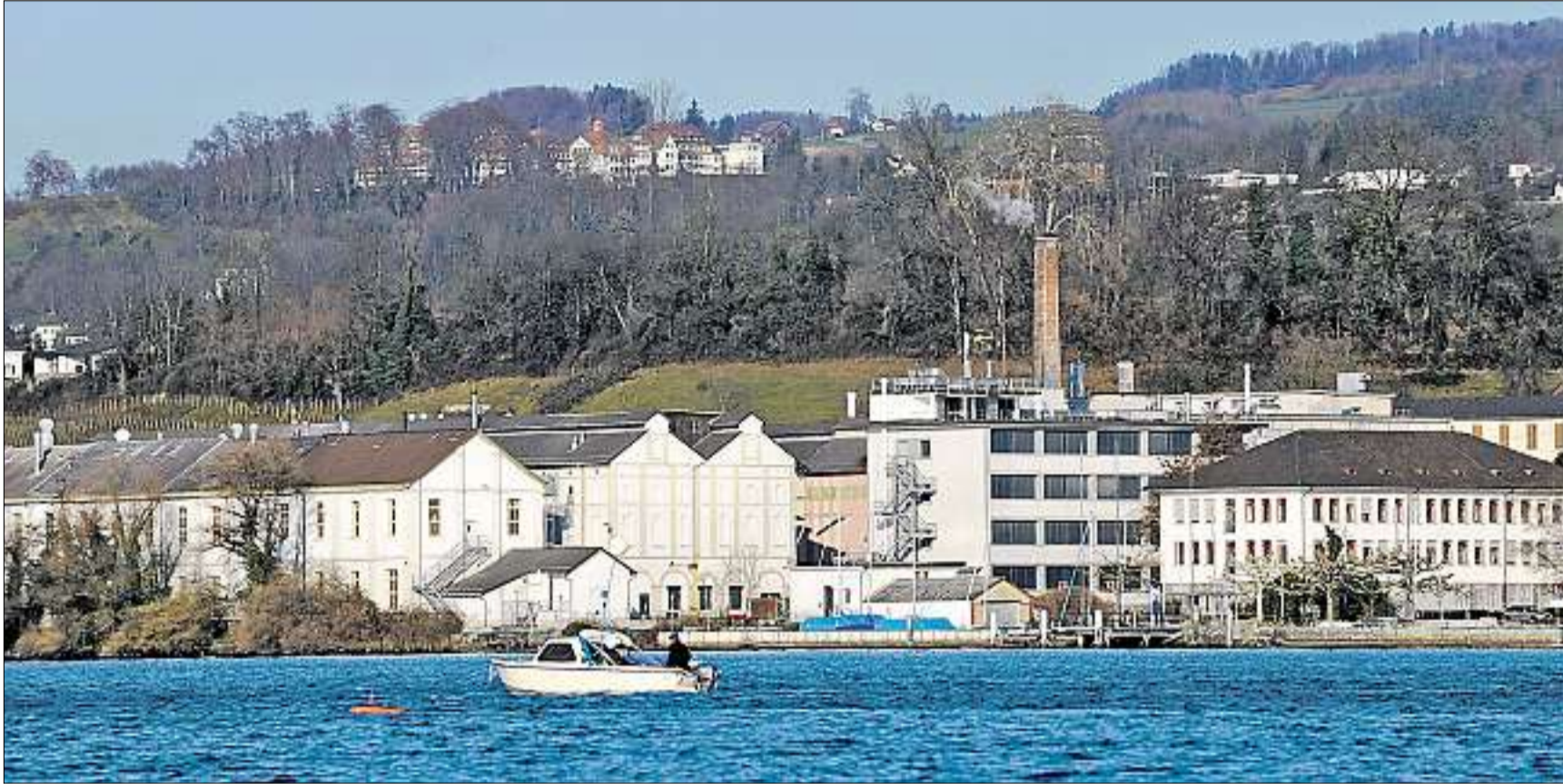
Entlang dem Ufer, vor den Fabrikgebäuden der CU Chemie Uetikon AG, soll künftig ein öffentlicher Weg führen – so will es der Zürcher Regierungsrat. (Reto Schneider)
